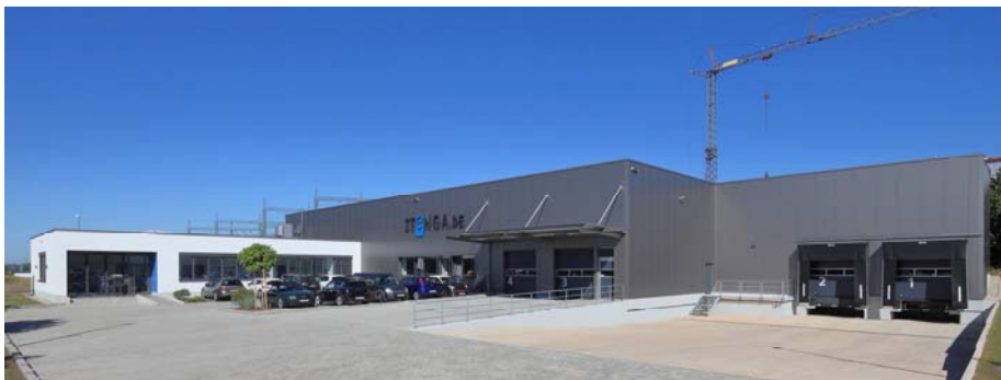
Neubau der itenga GmbH im interkommunalen Gewerbegebiet A1
