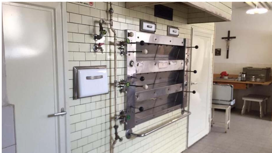
Nur BAELETC konnte einen sogenannten altdeutschen Dampfbackofen in einem Kloster in Bayern noch reparieren, die Anfang des 19. Jahrhunderts noch modernste Technik waren und traditionelle Backöfen mit feuererhitzten Backofensteinen ablösen.
