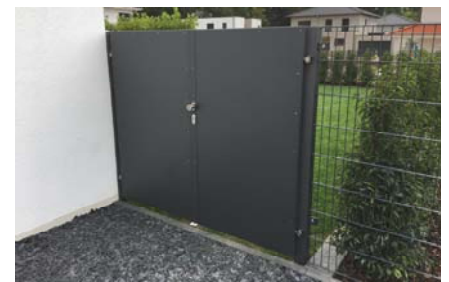
Beispiel einer kleinen Toranlage aus verzinktem Stahl für Privatkunden
