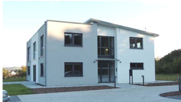
Das neue Domizil der Synergetik GmbH im Gewerbegebiet Am Nusskopf in Schiffweiler
