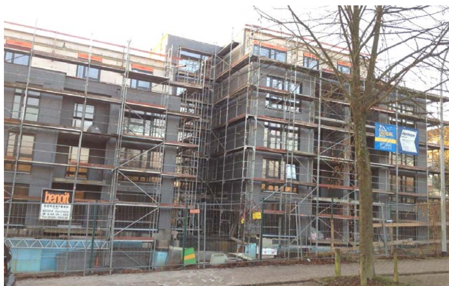
Vollwärmeschutz an einer Großbaustelle
