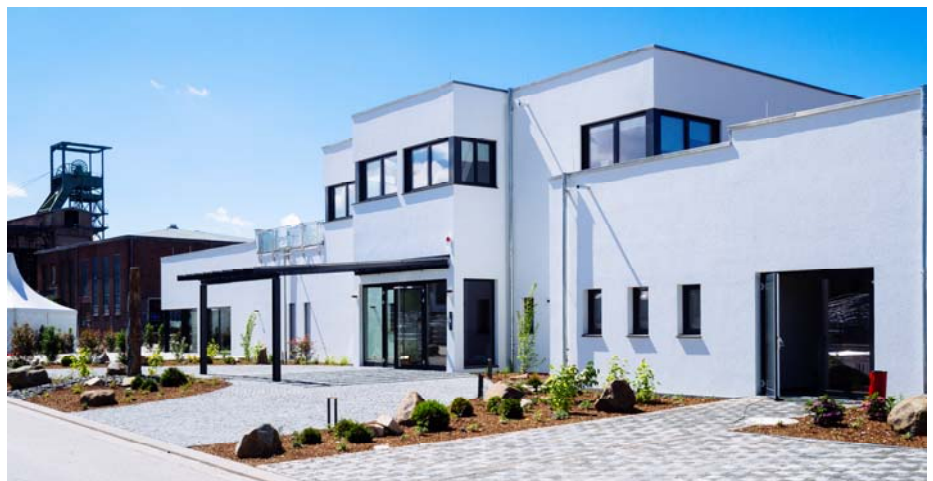
Der Neubau der proWIN Akademie ist eine Investition in die Zukunft vor historischer Kulisse. Im Hintergrund der Förderturm der ehemaligen Grube Reden.
