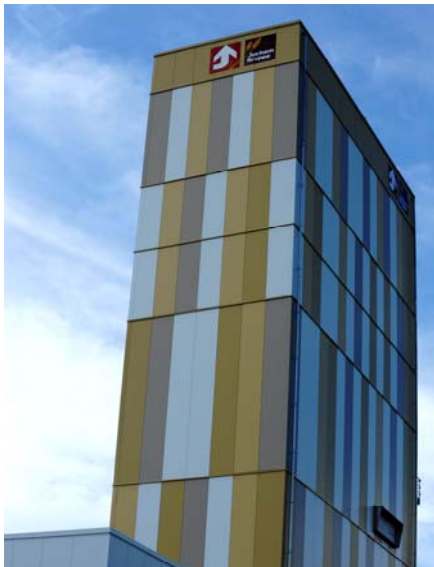
„Leuchtturm“: der neue, 37 Meter hohe Sprühturm von Juchem in Eppelborn.
