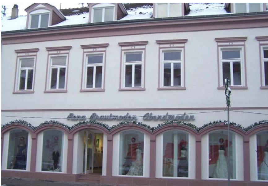
Eine Augenweide sowohl nach innen als nach außen: Die neuen Geschäftsräume im ehemaligen Ottweiler Kaufhaus gegenüber dem Landratsamt nach aufwendiger Umgestaltung der Fassade in Anlehnung an die Originalarchitektur aus dem Jahr 1900.
